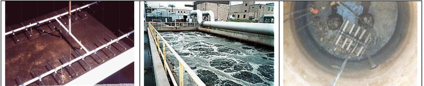
A eficiência dos difusores depende basicamente da profundidade a que são colocados (tempo de contato água/ar), do teor de sólidos (salinidade por exemplo), temperatura, altitude, etc..
