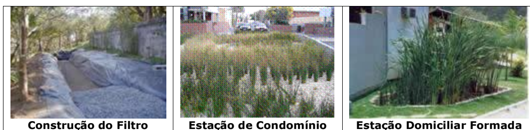
Construção do Filtro
