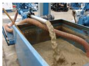
Drenagem de Lago
