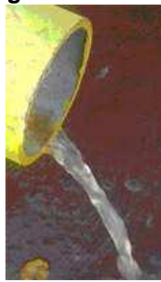
Área Preparada para Desague sobre Leito de Secagem com boca lateral
