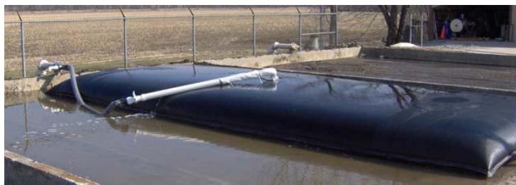
Filtração de Lodo em Leito de secagem
