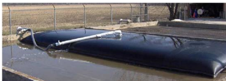
Filtração de Lodo em Leito de secagem
