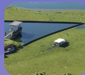
Barreira de Contenção em Estação de Captação de Água
