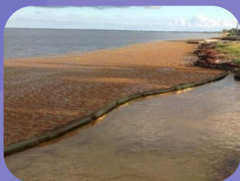
Barreira de Contenção no Mar
