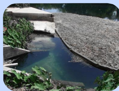
Barreira de Conteção em efluente
