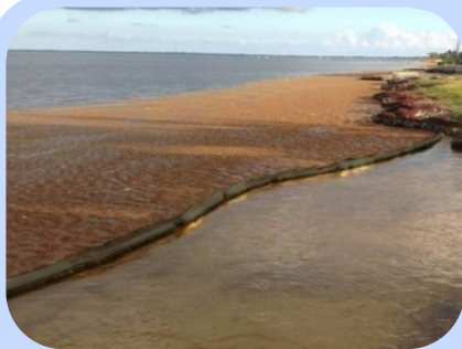
Barreira de Contenção no Mar
