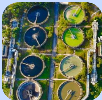
Desinfecção de esgotos e efluentes
