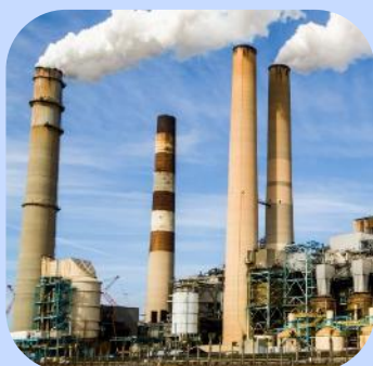
Tratamento de água para uso Industrial
